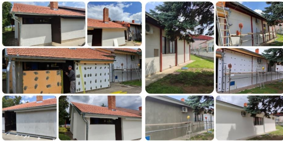
Слика 1. Реконструкција спољашњег дела Објекта
