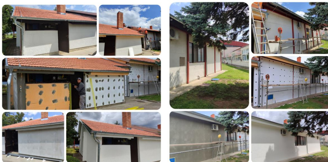
Слика 1. Реконструкција спољашњег дела Објекта
