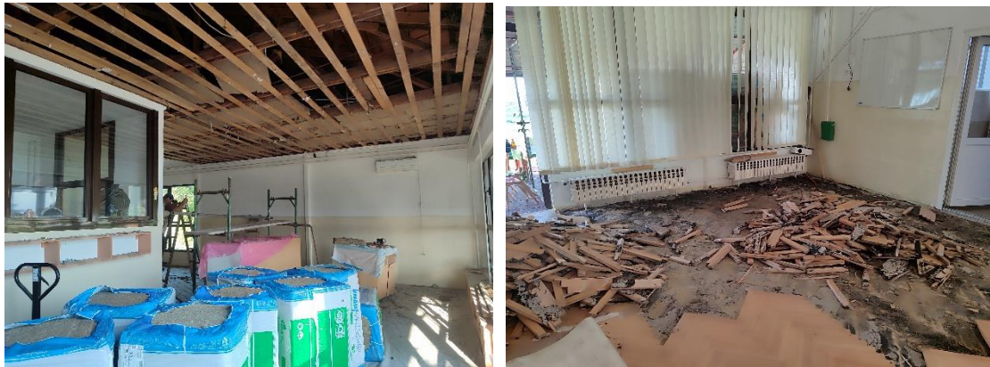
Слика 5. и 6. Радови на постављању плафона и поправка подова
