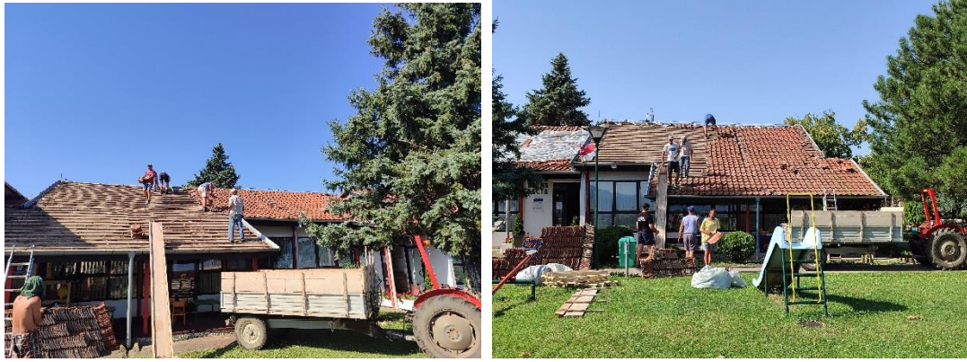
Слика 3. 4. Радови на замени кровне конструкције
