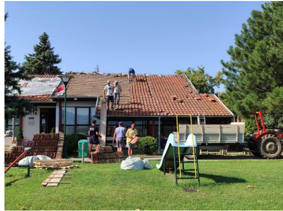
Слика 3. 4. Радови на замени кровне конструкције
