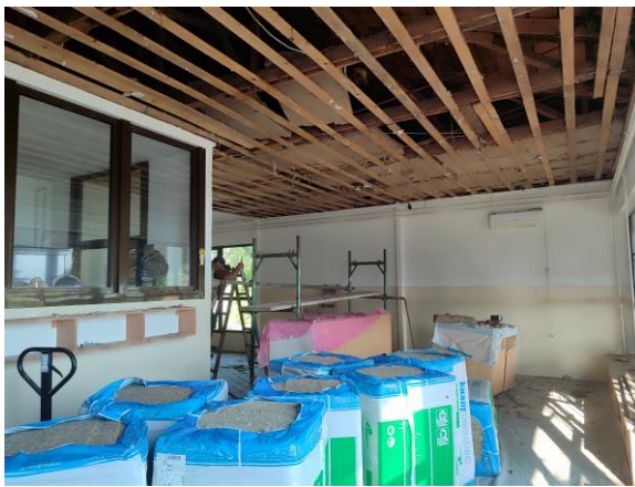
Слика 5. и 6. Радови на постављању плафона и поправка подова
