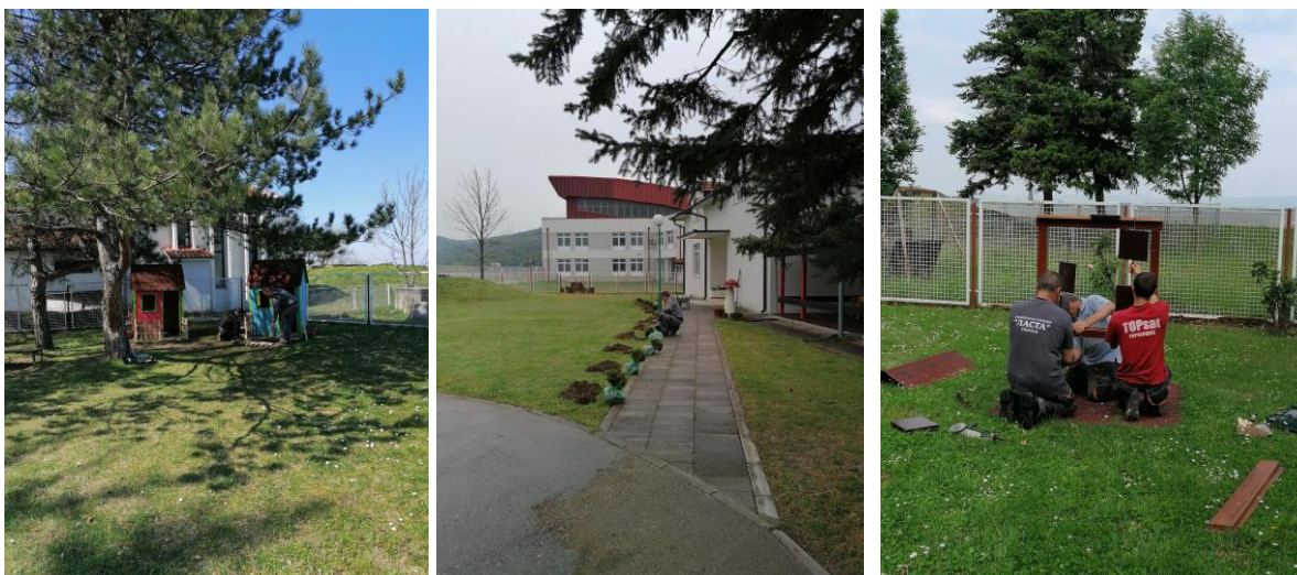
Слика 1. 2. и 3. Радови на Објекту 1 и 2.
