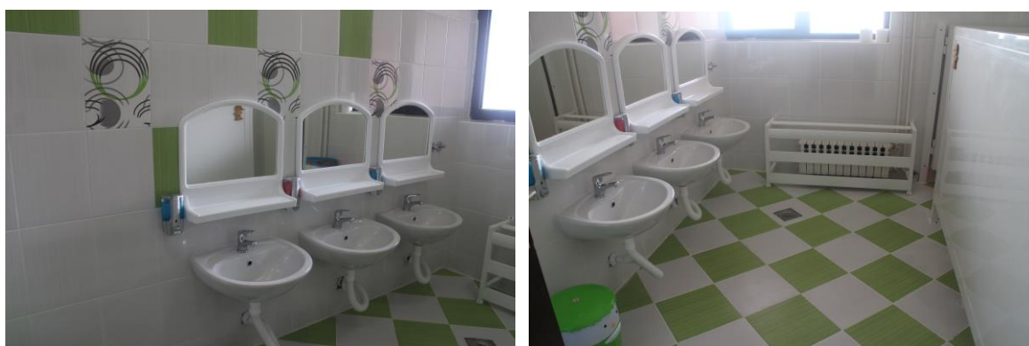
Слика 4. Изглед санитарних просторија јаслене групе после радова
